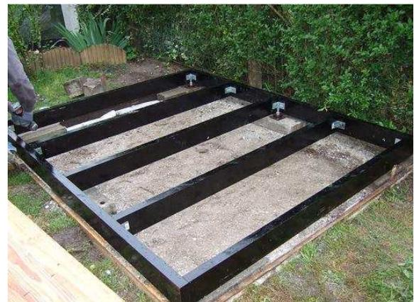
Montage du châssis, avec les équerres et les platines.
