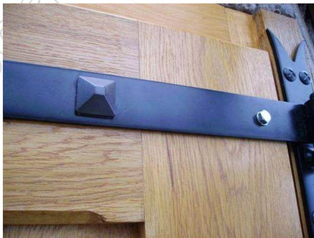
Pour rendre l'ensemble plus esthétique et cacher les vis disgracieuses des pentures, je les ai recouvertes de cache vis pointe de diamant
