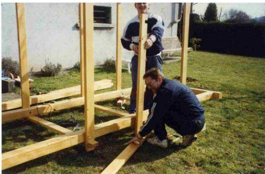
Avant d'assembler l'ensemble, il faut préparer les trous (les trous sont percés et lamés pour pouvoir passer une clé à pipe),
