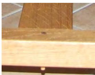
La mortaise dans la petite traverse basse (C) est à centrer. L'assemblage de la barre à chat (B) sera réalisé sur place avec une cheville (et sans collage).
