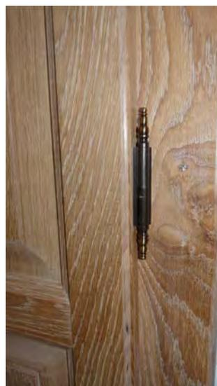
Ce type de paumelle se pose (à mon avis) plus facilement que des fiches à lacet. Réaliser un gabarit facilite énormément la pose.
