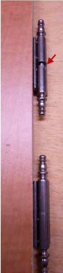
Un jour apparaît entre la partie inférieure et supérieure d'une des paumelles : ceci est dû à un mauvais positionnement d'une des paumelles.
