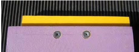
Remettre la pièce de PVC en place avec un peu de colle néoprène. Visser les cinq vis dans le PVC (utiliser des vis 3x12 en enlevant la pointe avec une pince coupante car on ne dispose que de 11 avant de rencontrer l'autre fer). Veiller à l'affleurement des têtes
