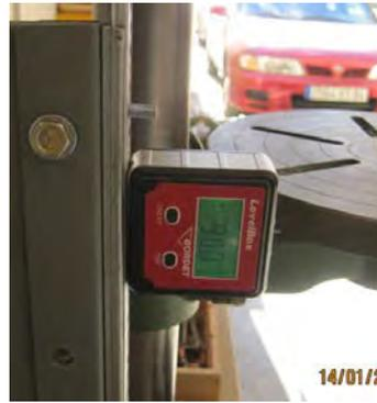
Fixer le support mural sur le mur avec quatre tirefonds. Ajuster sa position ; le montant central doit être bien vertical dans le sens gauche/droite. Ajuster également la position de la glissière dans le sens avant/arrière : il suffit de jouer sur la fixation du rail en U.
