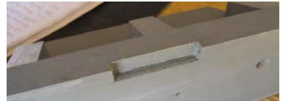
Sur le devant, débiter deux morceaux de rails en U (rideaux) de 320 de longueur et les coller et visser dans leur rainure. Boucher toutes les têtes de vis à la pâte à bois. Après séchage, poncer et mettre en peinture (j'ai utilisé la même peinture pour sols que celle de la table).
