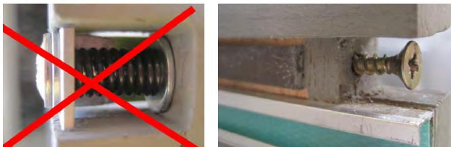
Sa vis de fixation a été remplacée par une plus longue (4x40) ; dans un premier temps, elle dépasse le fond de l'évidement de 13. La petite cornière fixée sur le mètre a été conservée, mais son trou est inutile. Désormais, elle s'appuie sur la tête de la vis. Une petite cale de 10x20 en PVC de 5 d'épaisseur, est maintenue par une cornière extérieure de blocage.
