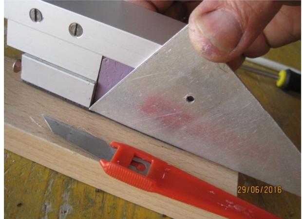
Façonner la cornière frontale selon le schéma et la percer de deux trous au Ø3
